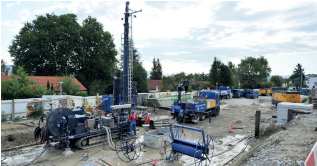
Abbildung 5: Bohrungen für den ersten Erdsondenspeicher der Familienheim-Genossenschaft Zürich (Bild: Matthias Kolb).
