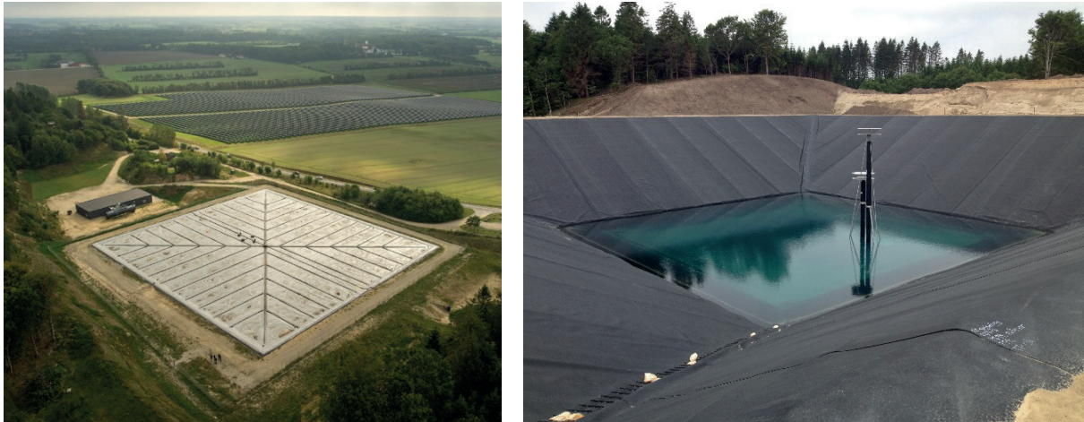
Abbildung 9: Erdbeckenspeicher von Dronninglund, DK (62'000 m 3 ) links: fertig mit Deckel; rechts: beim Befüllen (mit freundlicher Genehmigung von NIRAS, Aalborg).
