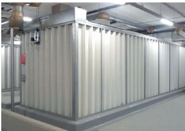
Abbildung 7: links: 60 m 3 Eisspeichervolumen für 273 Wohnungen in der Minergie-P Sanierung La Cigale in Genf (Bild: Energie Solaire SA); rechts: Eisspeicher der EWJR AG in Rapperswil-Jona mit enteisbaren Wärmetauschern vor dem Befüllen (Bild: SPF).
