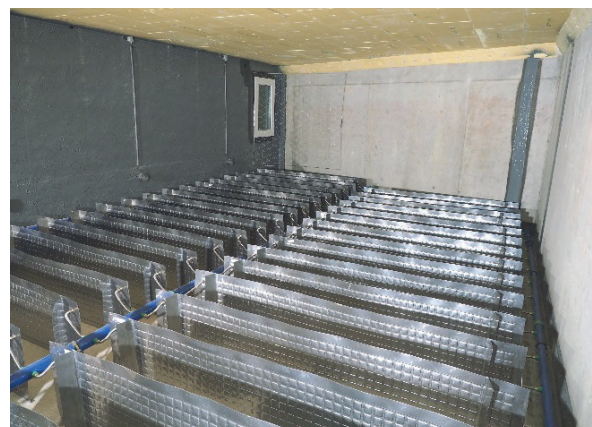
Abbildung 7: links: 60 m 3 Eisspeichervolumen für 273 Wohnungen in der Minergie-P Sanierung La Cigale in Genf (Bild: Energie Solaire SA); rechts: Eisspeicher der EWJR AG in Rapperswil-Jona mit enteisbaren Wärmetauschern vor dem Befüllen (Bild: SPF).
