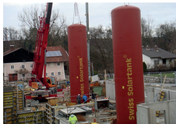
Abbildung 8: links: Transport eines grossen Wasserspeichers vom Werk auf die Baustelle per Sattelschlepper; rechts: Aufstellen der Speicher in Niedrigenergie-Solarhäusern in Deutschland (Bild: Jenni Energietechnik AG).
