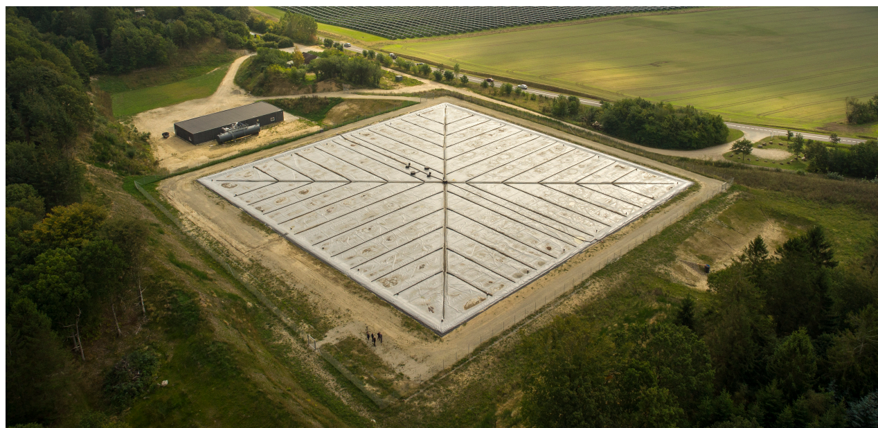
Wasser - Erdbeckenspeicher in Dänemark
